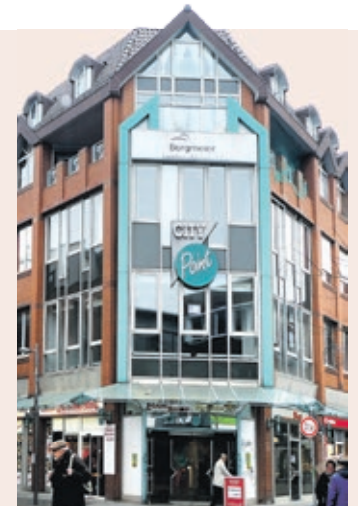
Der City-Point steht vor seinem Ende als Passage.
